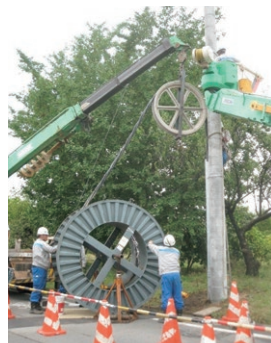
ケーブル入線工事
