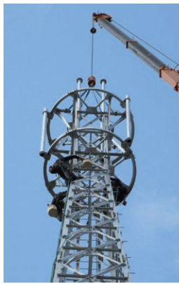
携帯電話基地局建設
