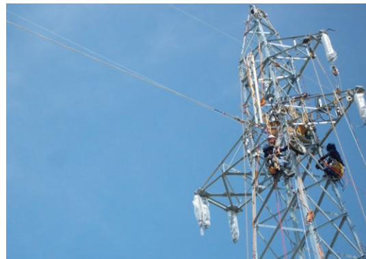
鉄塔架線工事
