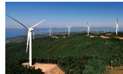
串間風力発電所
