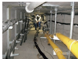
ケーブル敷設工事
