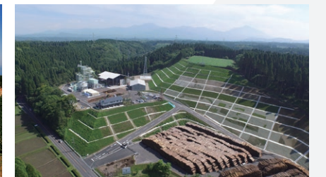
霧島木質発電株式会社
