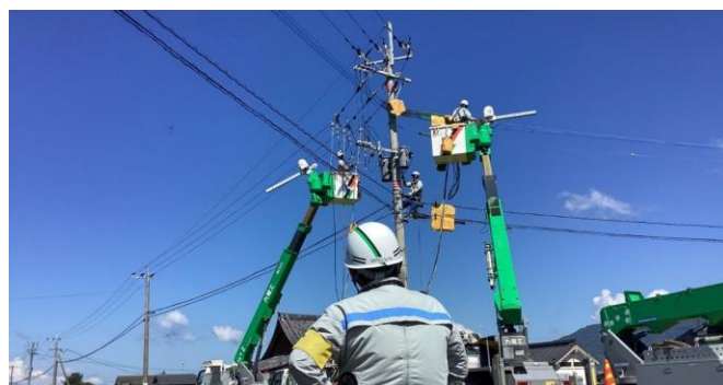
配電委託工事
