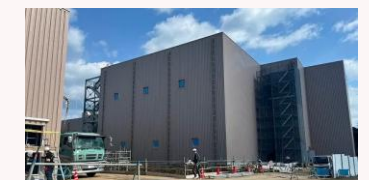
③建設中の交直変換所
