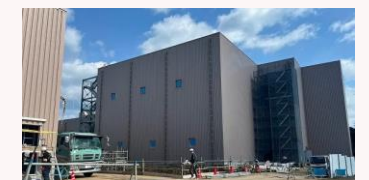
③建設中の交直変換所
