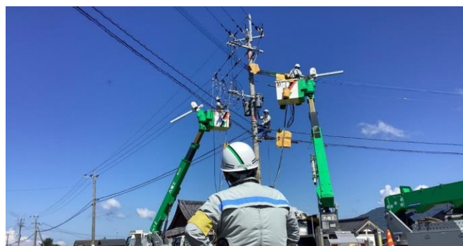
配電委託工事
