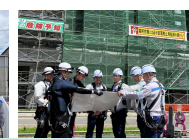
役員による安全巡視状況
