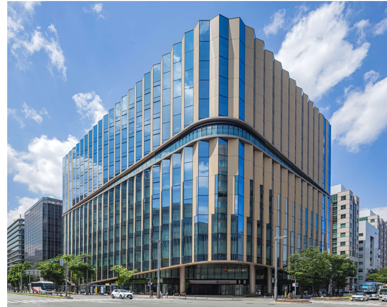
Walkプロジェクト新築工事
