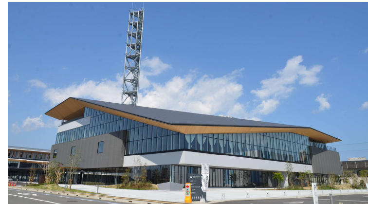
MRT宮崎放送移転新築工事
