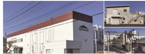
株式会社シャトレーゼ様 鹿屋工場 排水処理施設
